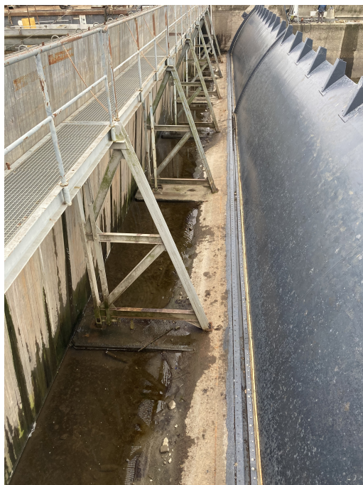
Foto č.5 – Horní hrazení a opravená přelivná plocha klapky
