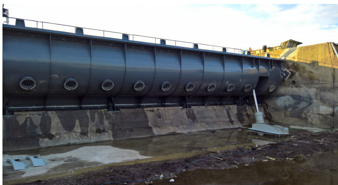
Foto č.2 – Pohled na klapku při opravě – VD Modřany
